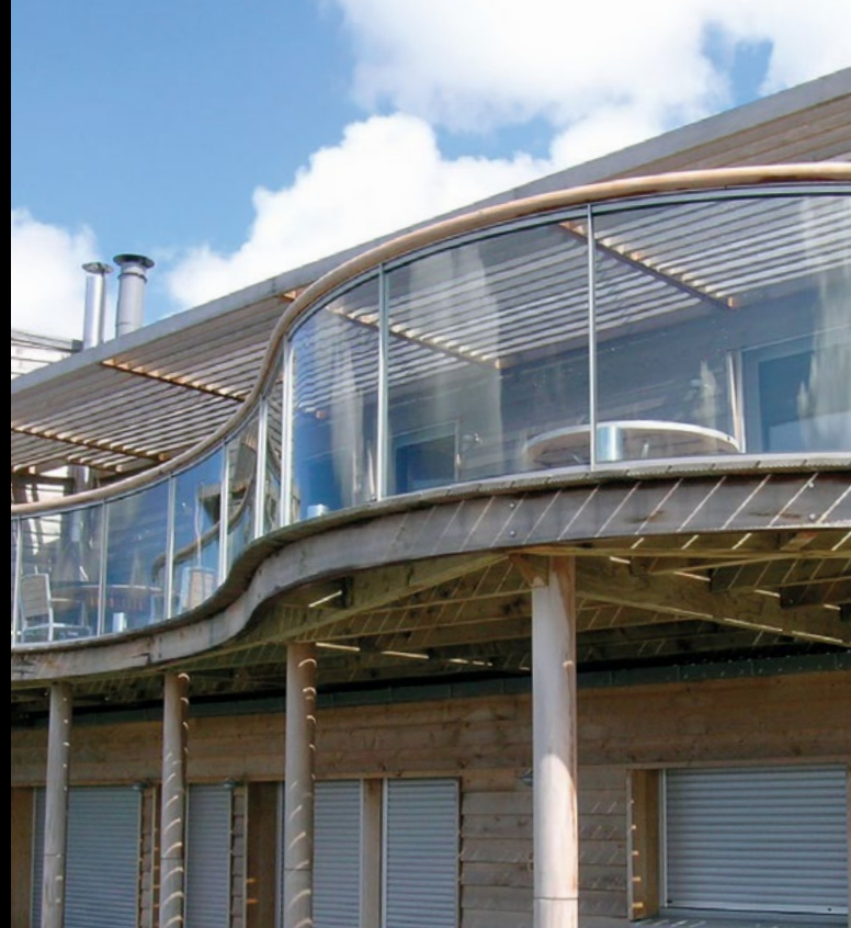
Garde-corps bombé, Villa en Bretagne Nord
